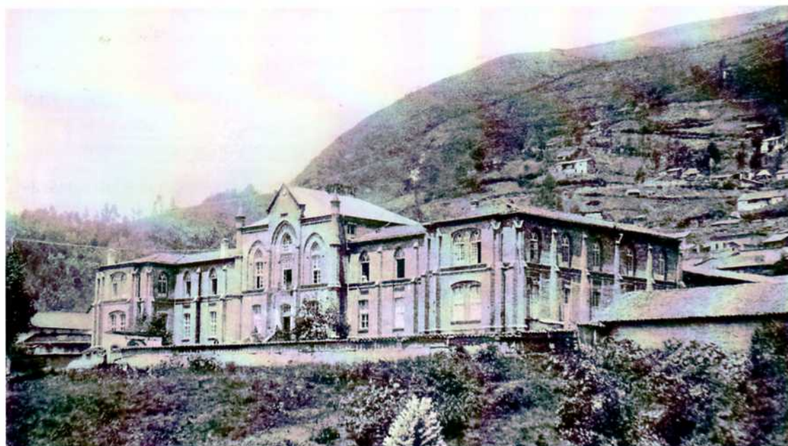
Fig. 3. Francisco Schmidt, antigua Escuela de Artes y Oficios (originalmente protectorado católico), 1872, Quito, fotógrafo desconocido, s. f.
